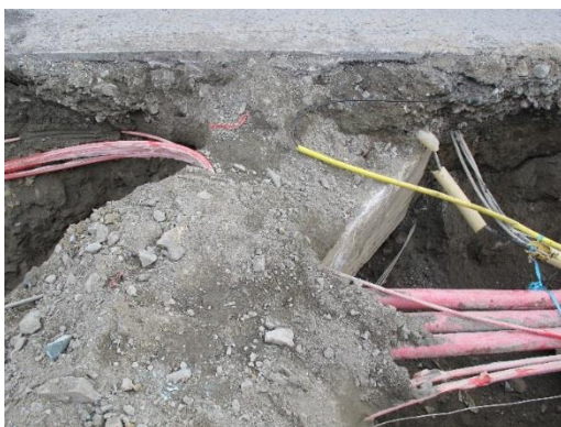
Figur 6. Kulverten og høyspentledningene litt før krysset til Sjøgata.
