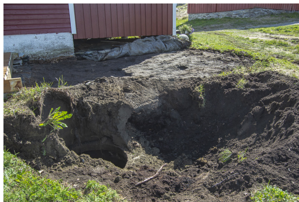
Figur 3 Sjakt mot utgravningsområde, før rensing. Betongkum til venstre.
