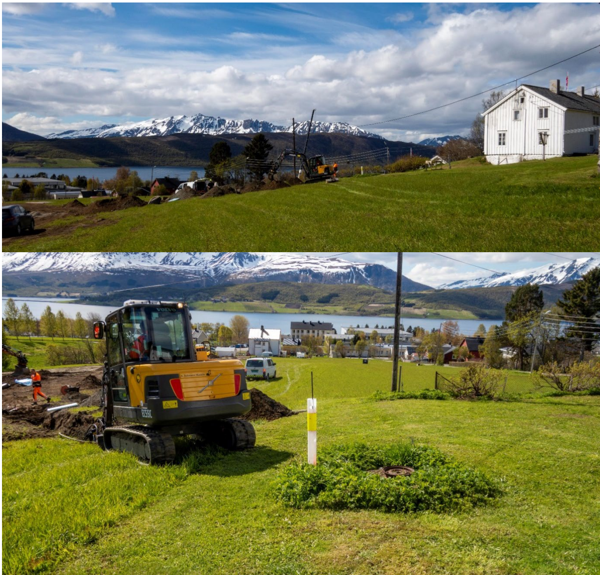
Figure 4 Sjaktene ble gravd ved å sikte seg mot eksisternde septiktank, markert med hvit pinne på nederste bilde
