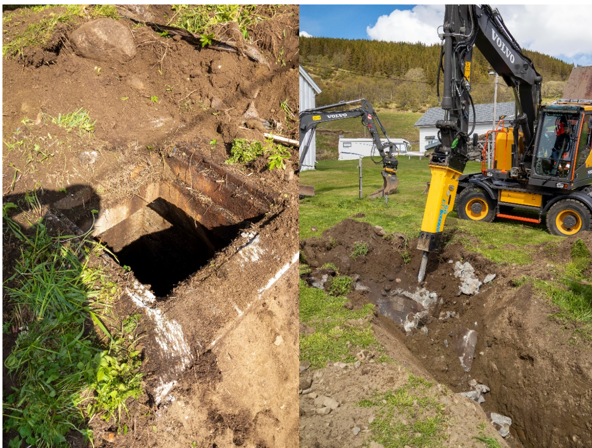
Figure 6 Eksisterende septiktank som ble slått ned med en større maskin mepåmontert trykklufthammer
