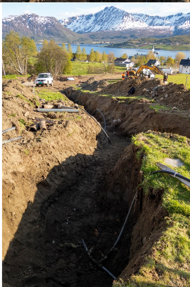
Figure 7 Situasjon etter graving var avsluttet
