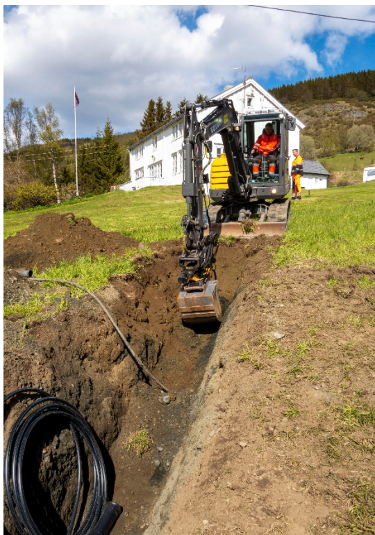
Figure 3 6-tonns gravemaskin som sjakter i eksisterende kabeltrase. Gammel galvanisert vannledning kan sees stikkende opp til venstre i sjakten.
