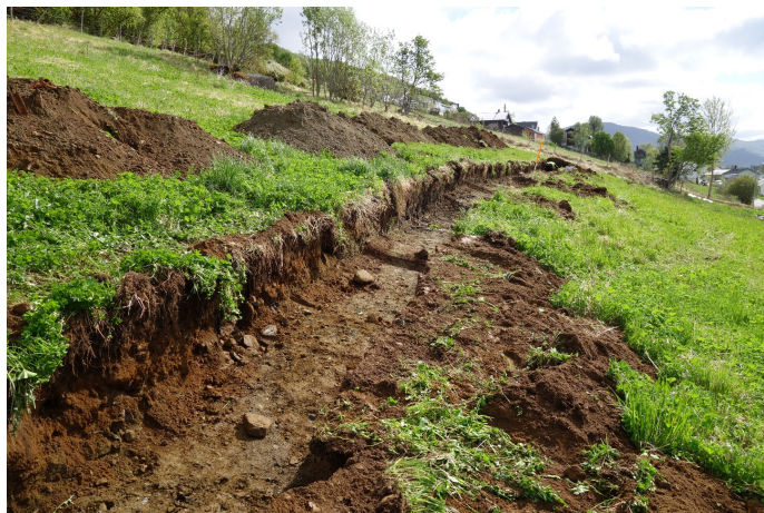
Figur 3 Sjakta i det klart hellende terrenget.
