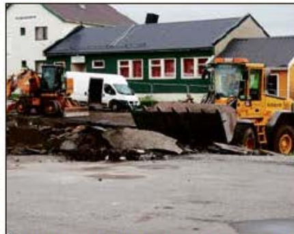
IGANG: Nå har idarstignalet for flerbrukshuset gått, og arbeidene er i gang med å grave ut tomte.
