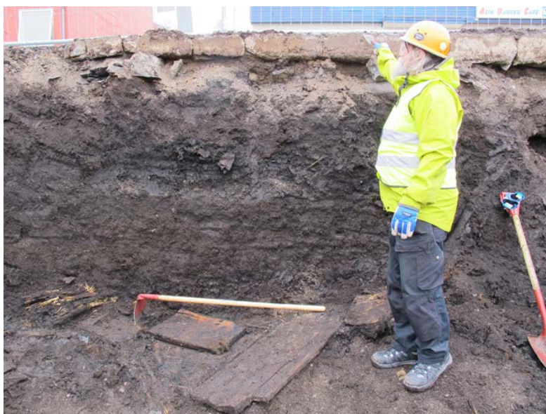
Figur 16 Fortauet hviler kun på et tynt lag pukk, under dette følger kulturlag i 3,5 meters dybde. På bildet sees sagde planker fra nyere tid, over disse delvis torvomdannet dyremøkk, over dette igjen mengder lær- og skinnrester.
