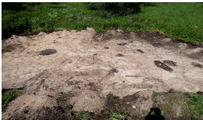
Figur 25 oversiktsbilde før inngrep
