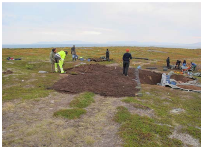
Figur 78 Geoduk legges på kjørsporet på id. 18734 for å holde på plass masser. 18.9.2014
