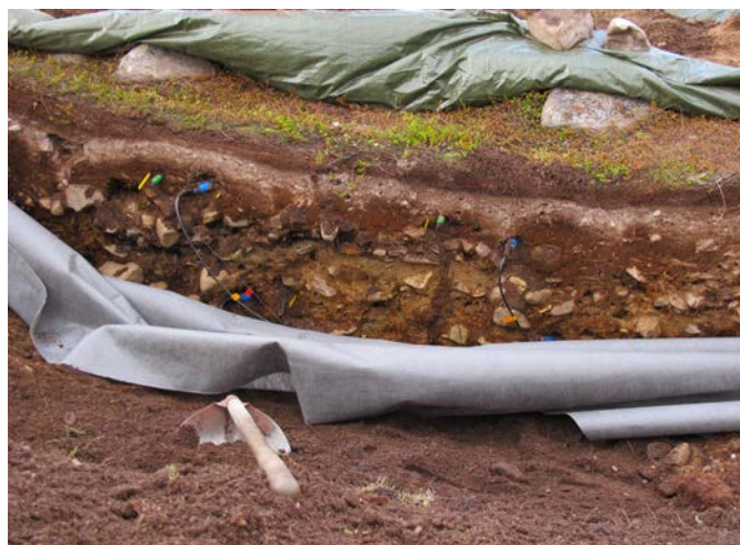
Figur 81 Overvåkingssutstyret er installert og profilen skal legges igjen. 19.9.2014
