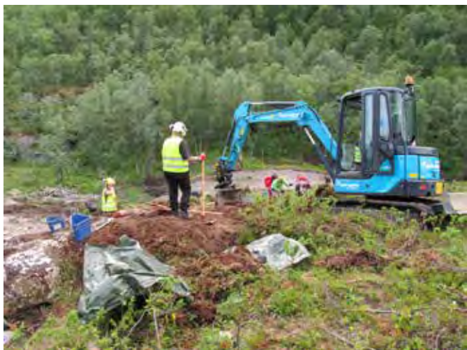
Figur 81 Avtorving av bruddet med en liten gravemaskin, deretter ble torv og vegetasjonsrester rensset for hånd.
