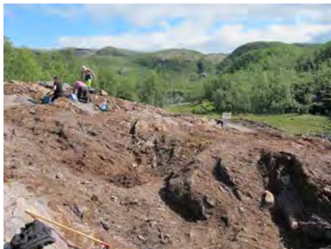
Figur 81 Avtorving av bruddet med en liten gravemaskin, deretter ble torv og vegetasjonsrester rensset for hånd.
