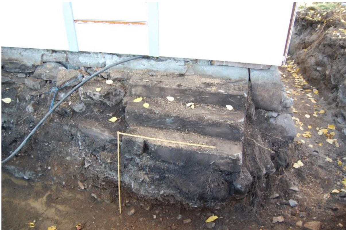
Fig. 19. Trappa i grunnmuren ved tilbygget på sørsida. NNV. Foto: Anders Christian Nilsen
