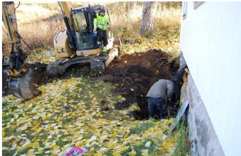
Fig. 7. Arbeidet starter på nordsiden av huset. T.v.: maskinfører Sigurd Hansen. T.h.: tiltakshaver Tore Varmedal. Bildet er tatt mot Ø. Foto: Anders Christian Nilsen
