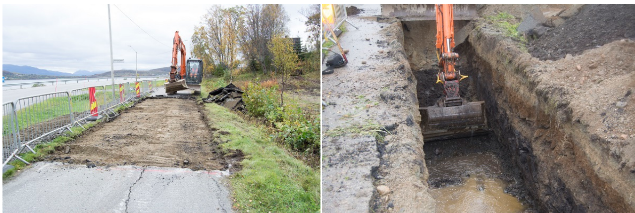
Figur 4 Sjakta ble åpnet i flere ledd, t. v. fjernes asfalten i den første sjakta, den 28.09.15. T. h. bunnen av sjakt gravd den 30.09.15.
