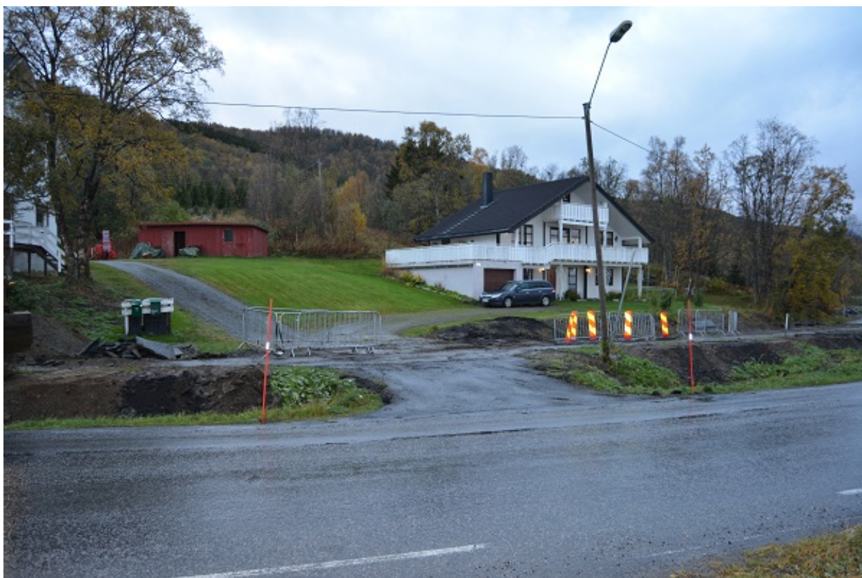
Figur 5 Foto av Stornesveien 231, med 229 helt til venstre i bildet. Sjakta ble gravd i gang- og sykkelstien i forkant av tomta. 01.10.2015.
