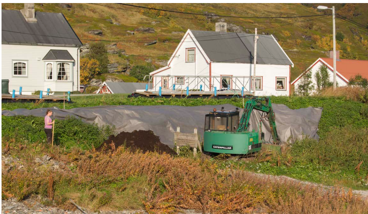
Figur 6 Tildekking av gårdshaugen med fiberduk og jord
