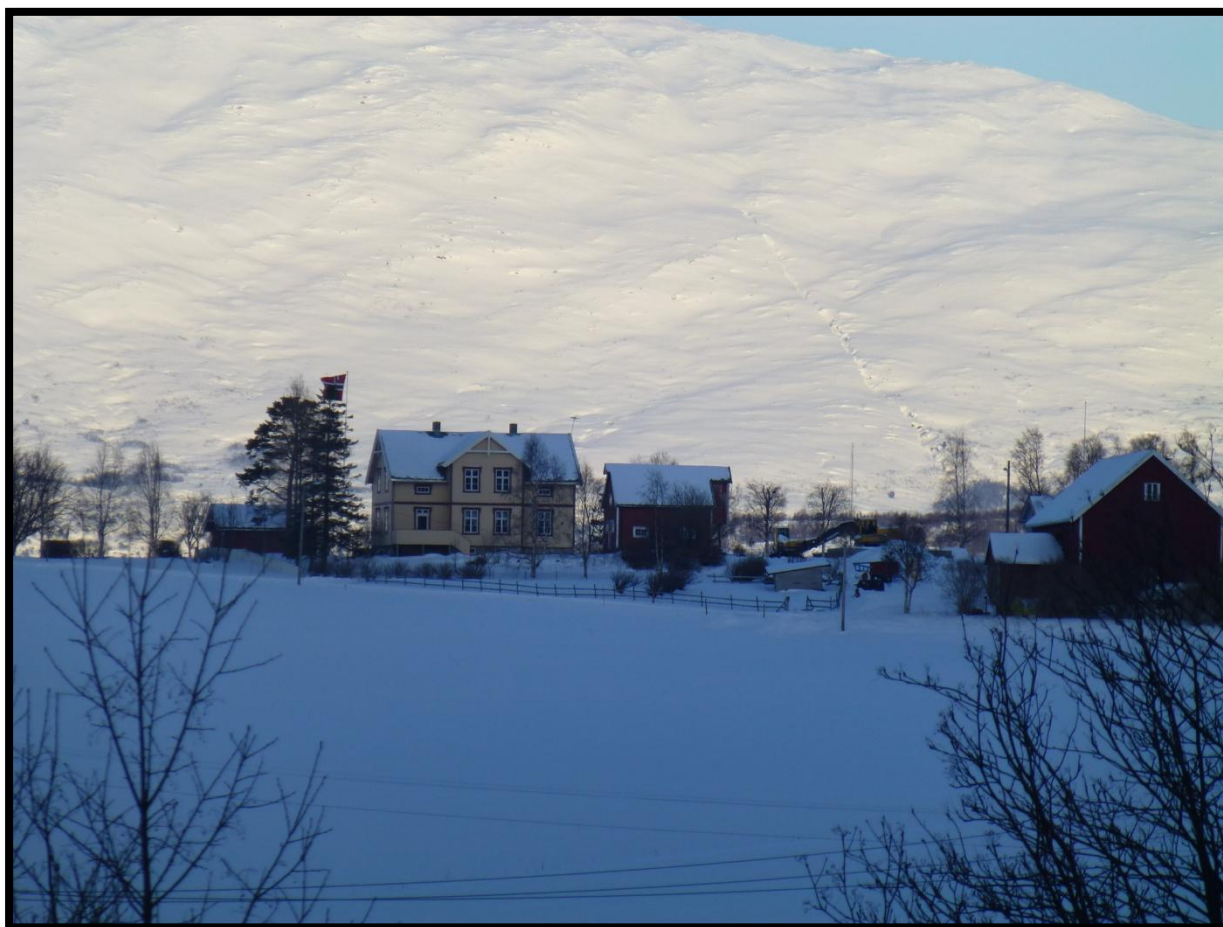
Skjerstad sett mot nord 06.02.2013. Fra høyre ses låven, i bakkant ligger garasjen. Gravemaskinen står ved byggetomta på gårdshaugen. På naboeiendommen i vest ligger prestegården (gult hus) mot venstre i bildet. Foto: Stine Grøvdal Melsæther
