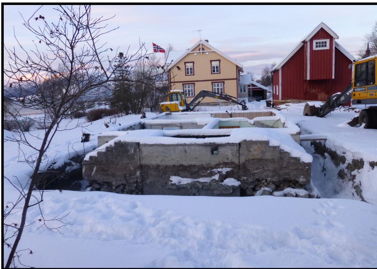
Byggetomta på Skjerstad etter graving, sett mot vest 06.02.2013. Foto: Stine Grøvdal Melsæther.
