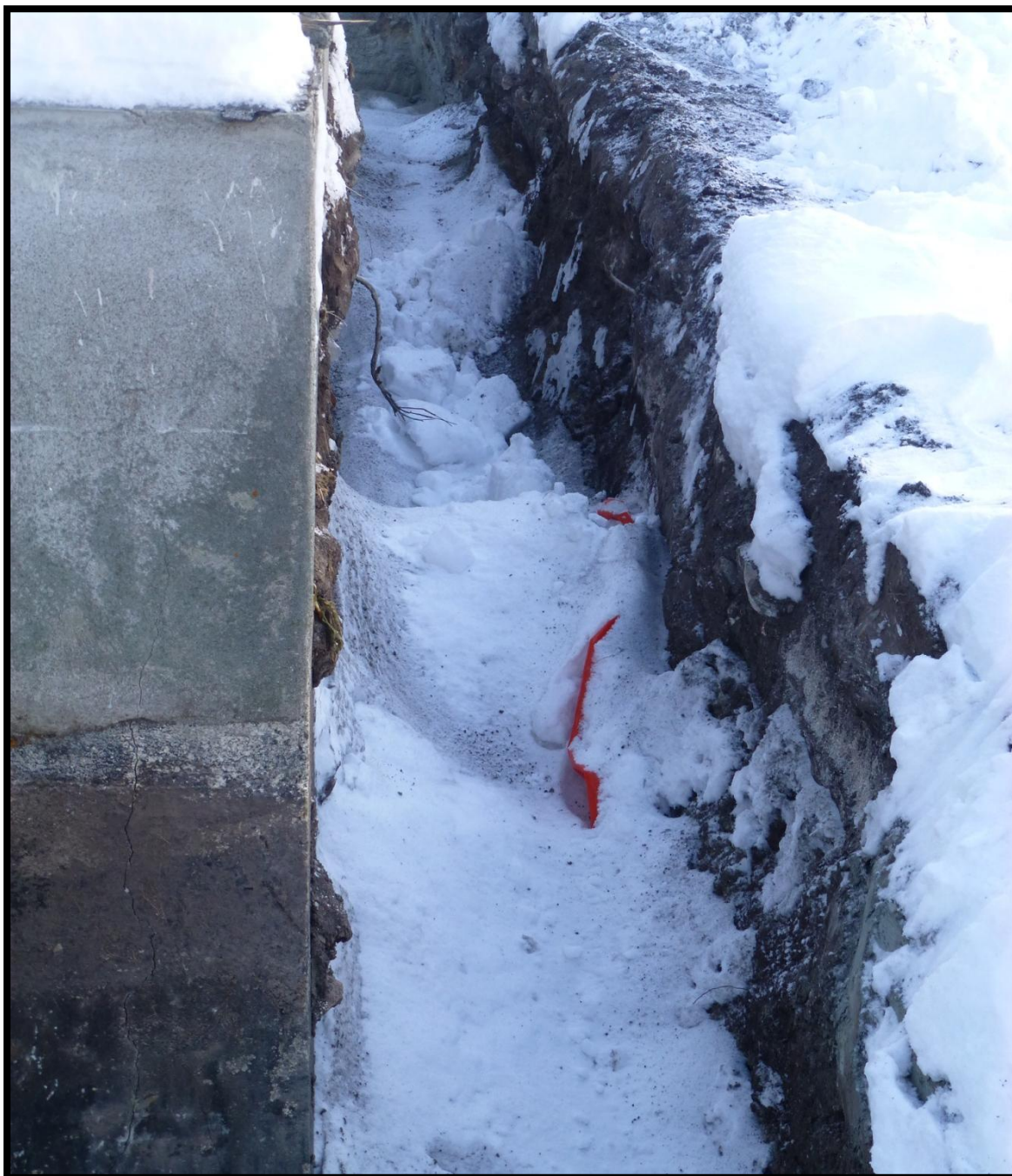
Profil i grøft S 06.02.2013. Sett mot øst. Til venstre er husfundamentene, og til høyre skimtes lag 2 i profil. Foto: Stine Grøvdal Melsæther
