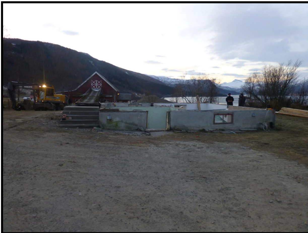
Husfundamentet til den gamle eneboligen på gårdshaugen 13.12.2012. Bildet er tatt mot sør. Foto: Stine Grøvdal Melsæther
