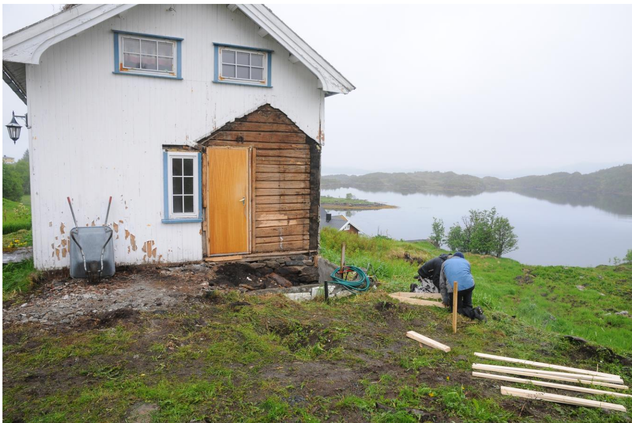
Figur 1. Nordsiden av hovedhuset med spor etter det fjernede tilbygget og betongplattingen. Bilde tatt mot sørvest. Foto: Rudi J. A. Mikalsen. 2011
