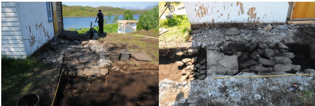
Figur 14 og 15. Henholdsvis hellelag K301 i sjakten mot vest og steinlag under hellene. Sett mot vest og sør. Foto: Rudi J. A. Mikalsen. 2011.
