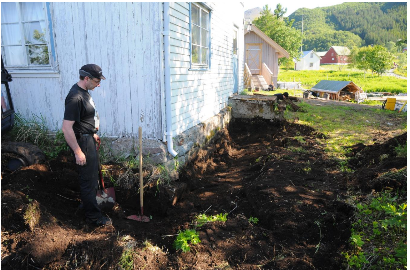
Figur 3. Graving av drenering rundt hovedhusets sørøsthjørne. Bilde tatt mot nord. Foto: Rudi J. A. Mikalsen. 2011
