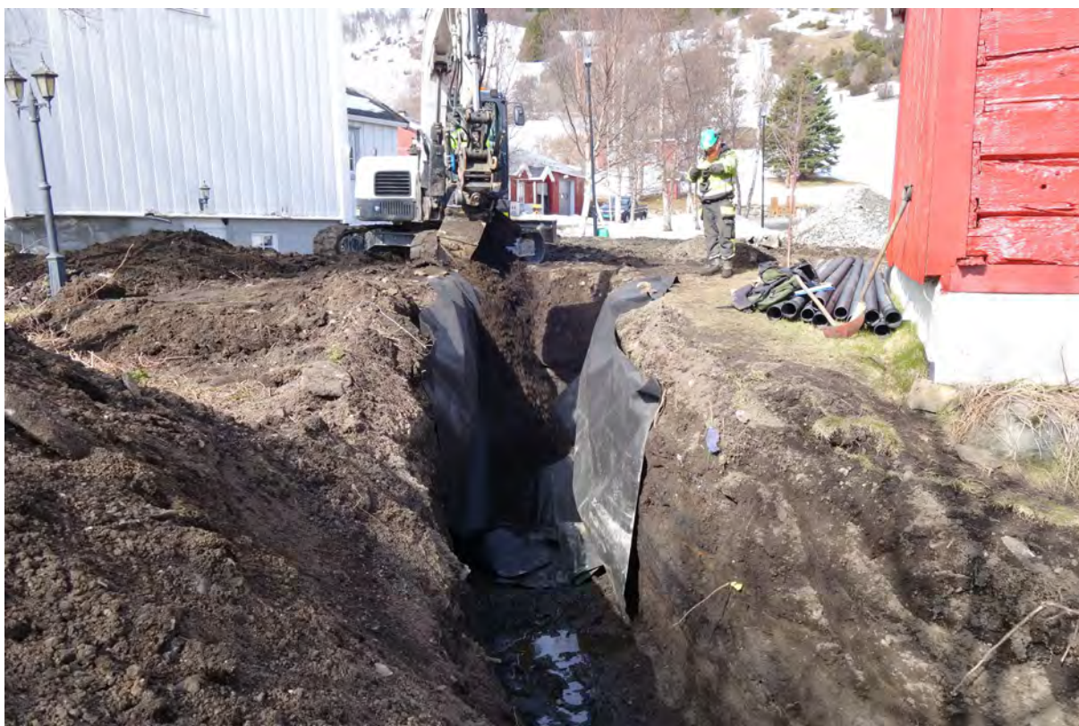
Figur 11 Gjenlegging av sjakt 1
