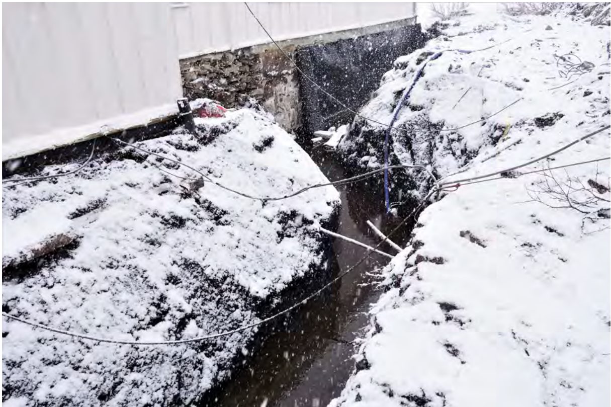
Figur 2 Grøft til ny drenering. Vannsig (1 natt), ca. en tredjedel av sjakt er fylt
