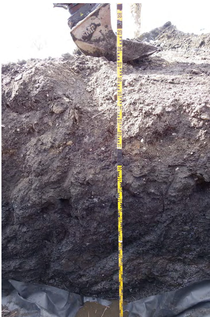
Figur 8 Grøftkantene mot vestsørvest, sjakt 1
