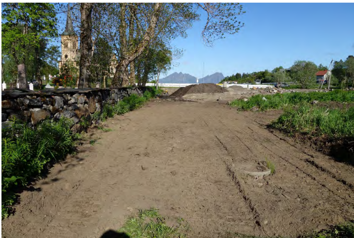
Figur 19 Ferdig gjenlagt/ under gjenlegging/oppretting. Mot øst, Lofotkatedralen i bakgrunn
